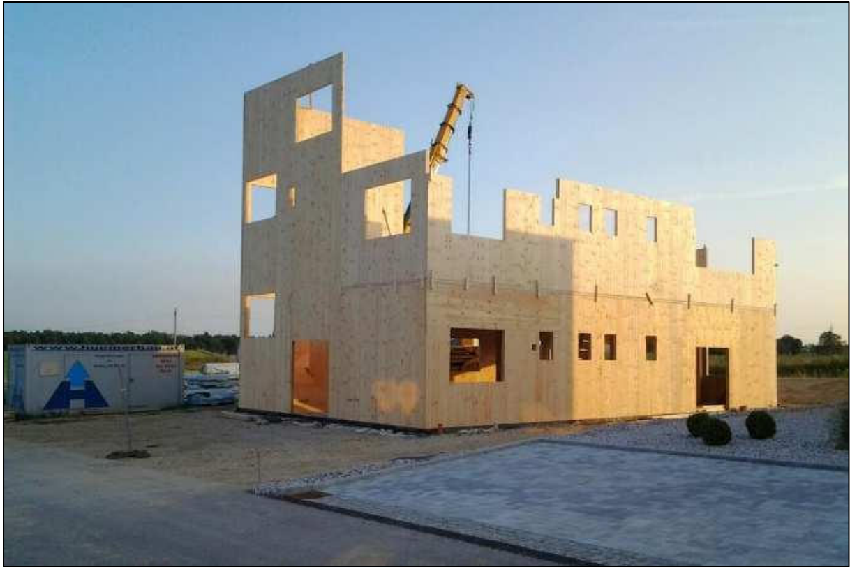
Abbildung 20 - KLH-Massivholzbauweise Innenansicht
