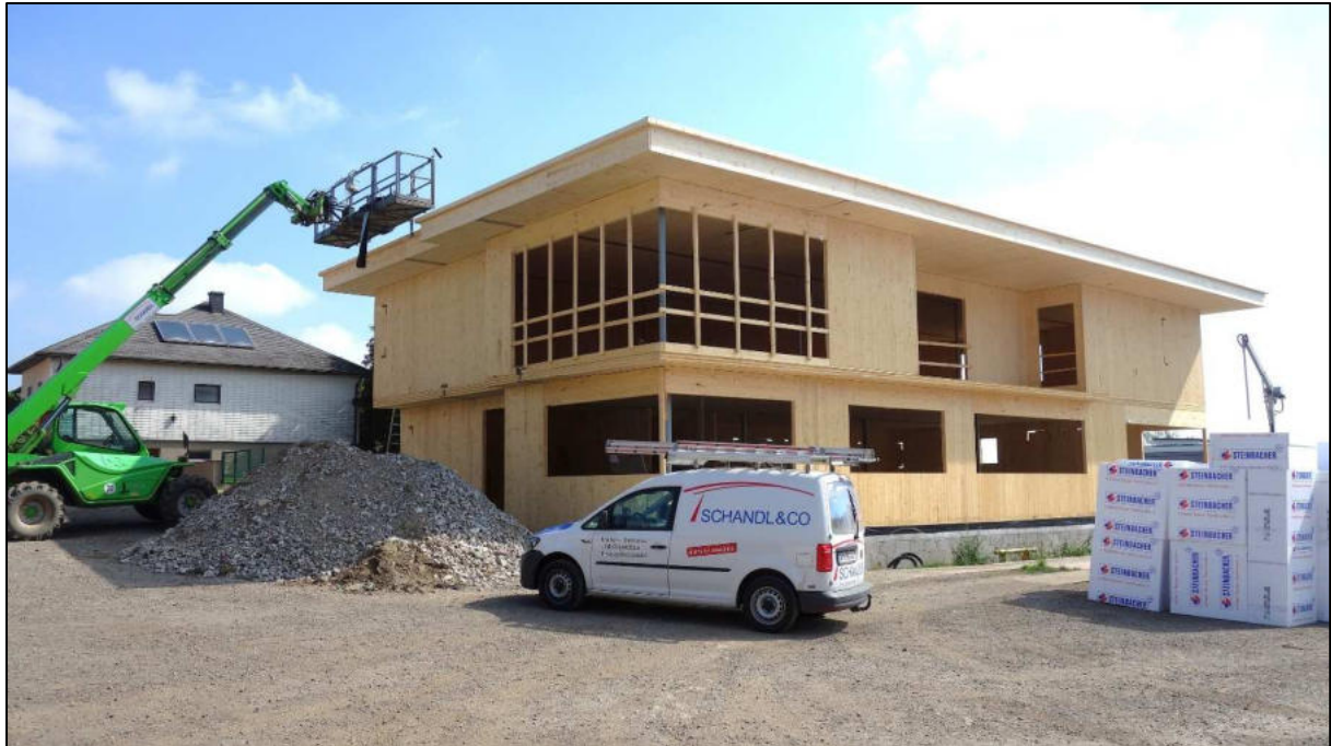
Abbildung 18 - KLH-Massivholzbauweise
