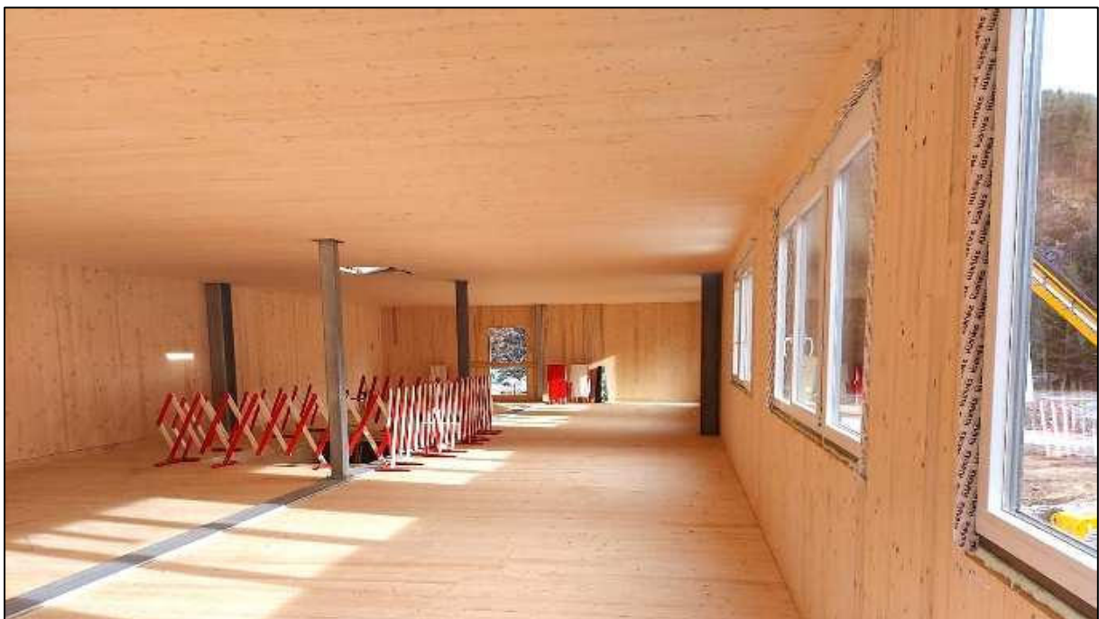
Abbildung 20 - KLH-Massivholzbauweise Innenansicht
