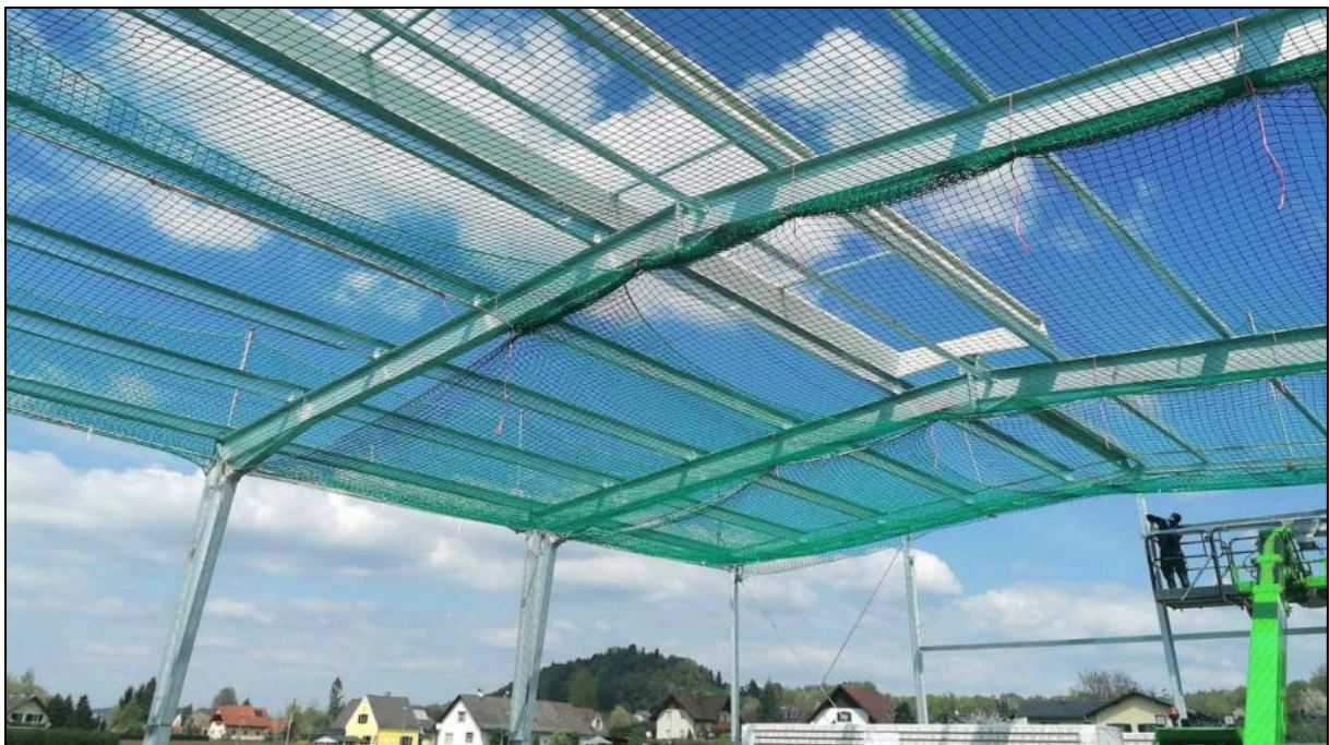
Abbildung 28 - Absturz- inkl. Durchsturzsicherung
