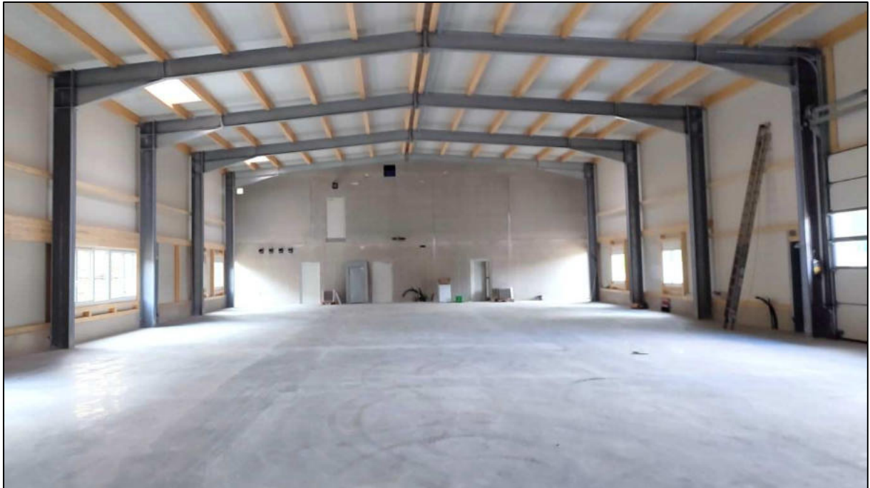
Abbildung 8 - Stahl-Rahmenbinder mit Holzpfetten
