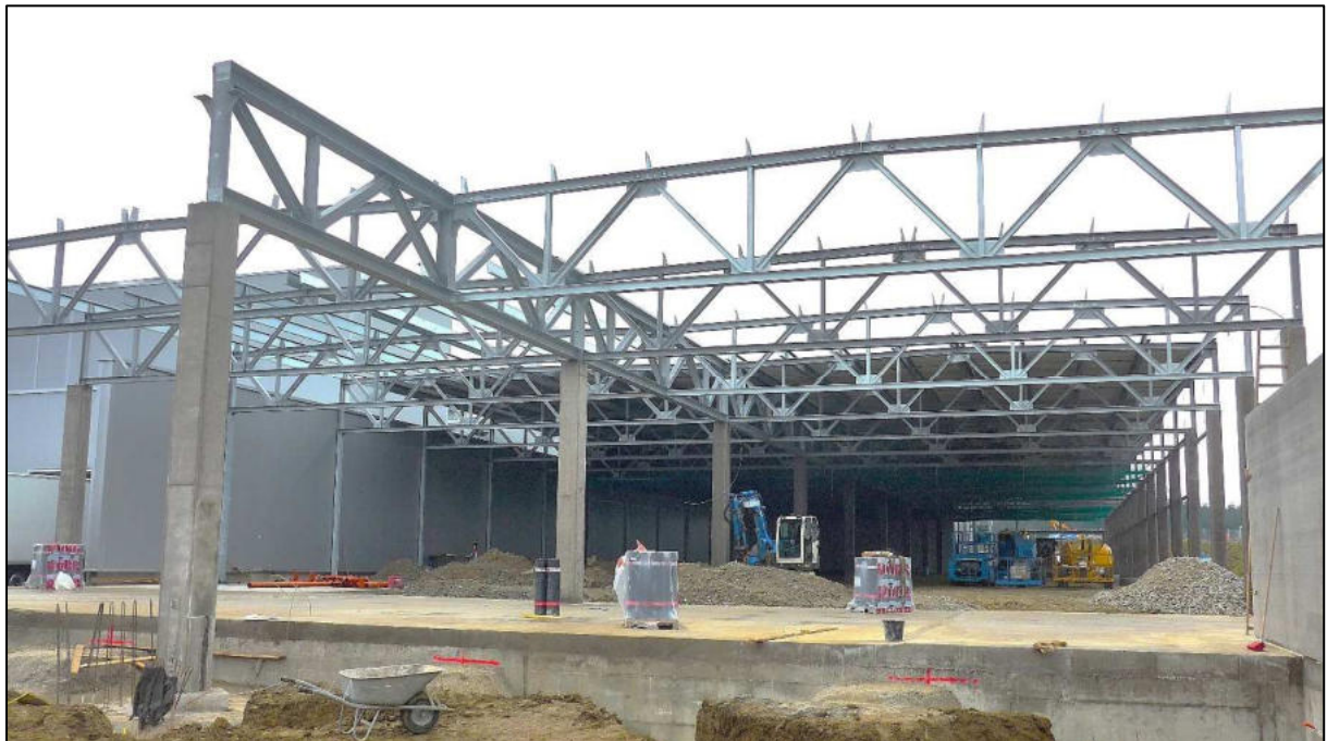
Abbildung 11 - Stahl Fachwerke Flachdach
