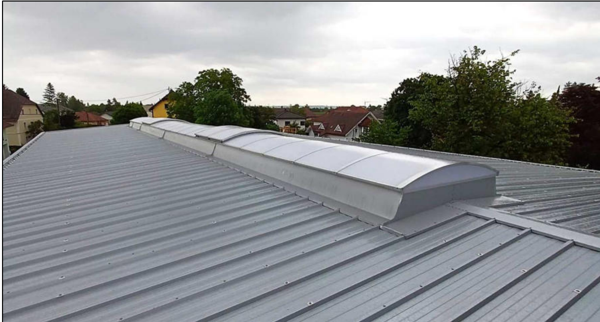
Abbildung 36 - Dachbelichtung mittels Lichtband (Ausführung auch als RWA-Rauch-Wärmeabzug möglich)
