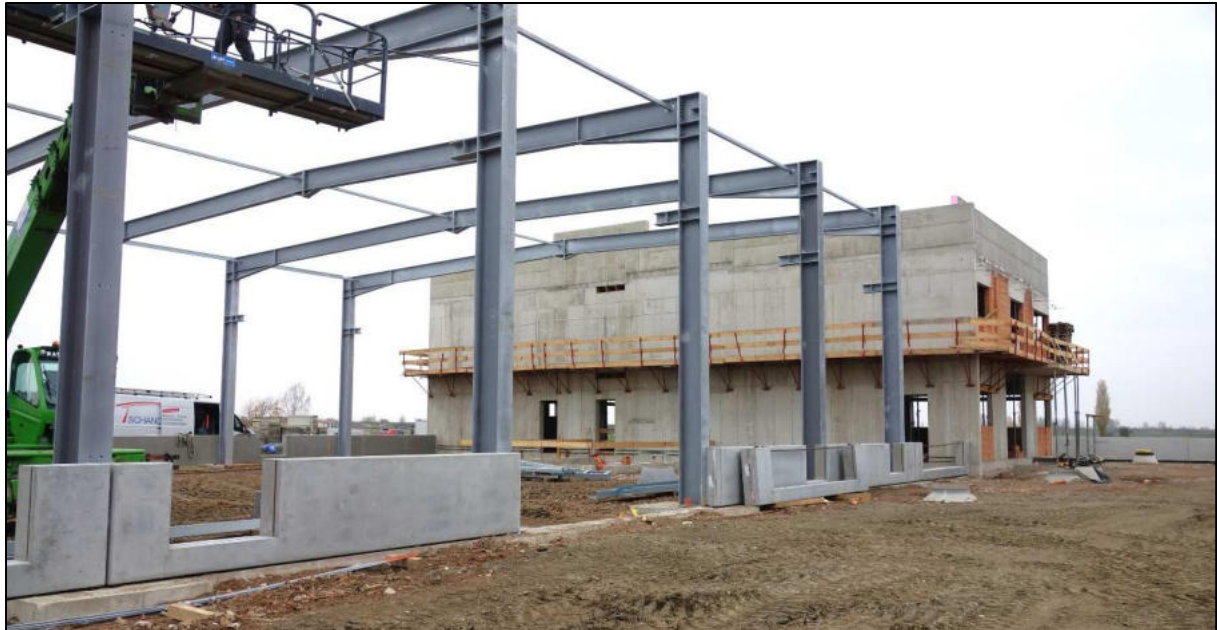
Abbildung 21 - Beton-Fertigteilsockel
