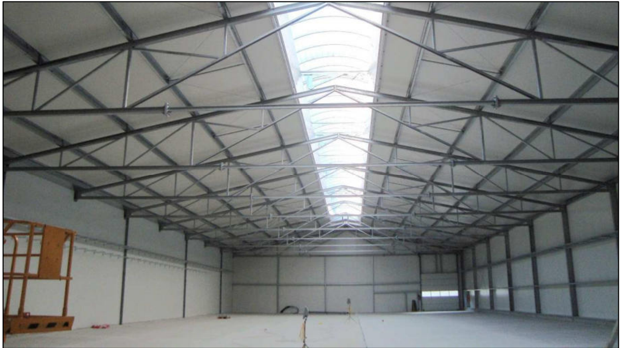
Abbildung 10 - Stahl-Fachwerke Satteldach
