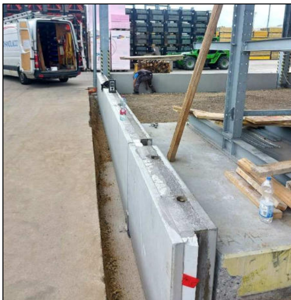
Abbildung 22 - Beton-Fertigteilsockel mit Dämmung
