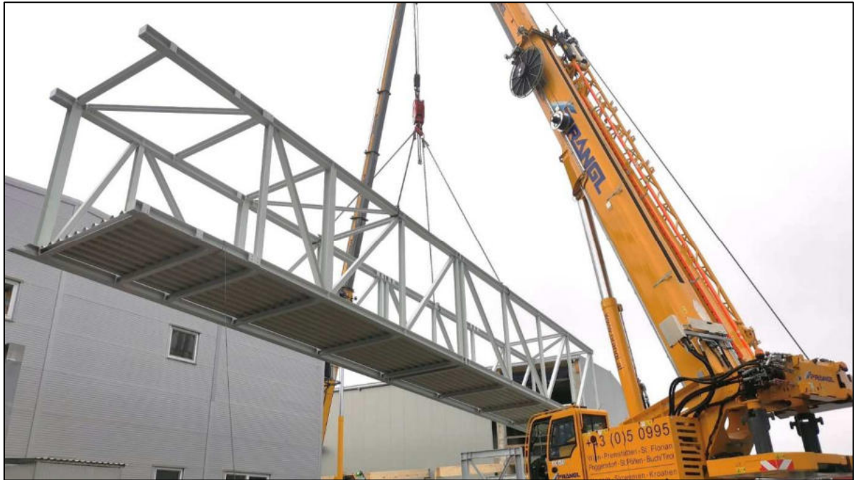
Abbildung 53 - Stahl-Verbindungsbrücken freitragend
