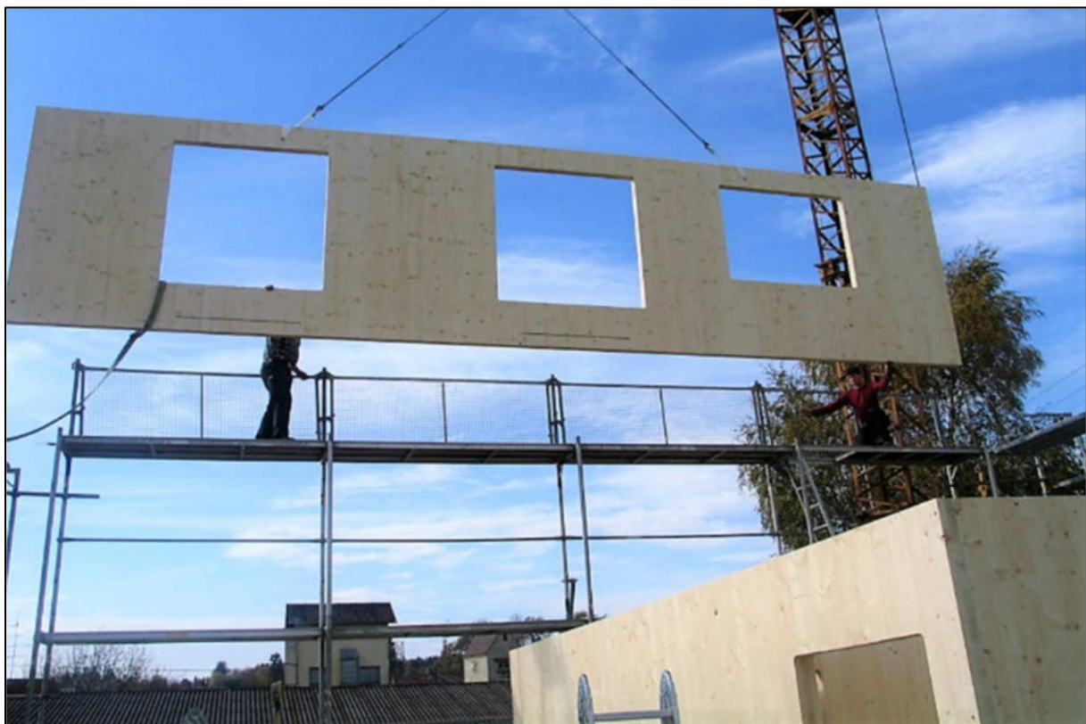
Abbildung 18 - KLH-Massivholzbauweise
