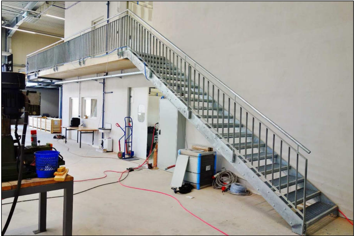
Abbildung 48 - Stahlstiegen, Stiegentürme, Geländer
