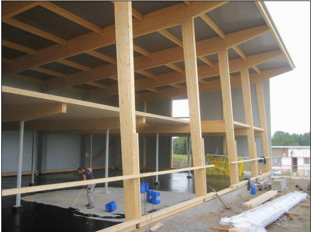
Abbildung 16 - Leimholz-Pultdachbinder mit Holzstützen
