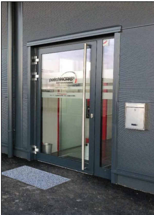
Abbildung 40 - Außentüre Alu vollverglast (auch teilverglast möglich)
