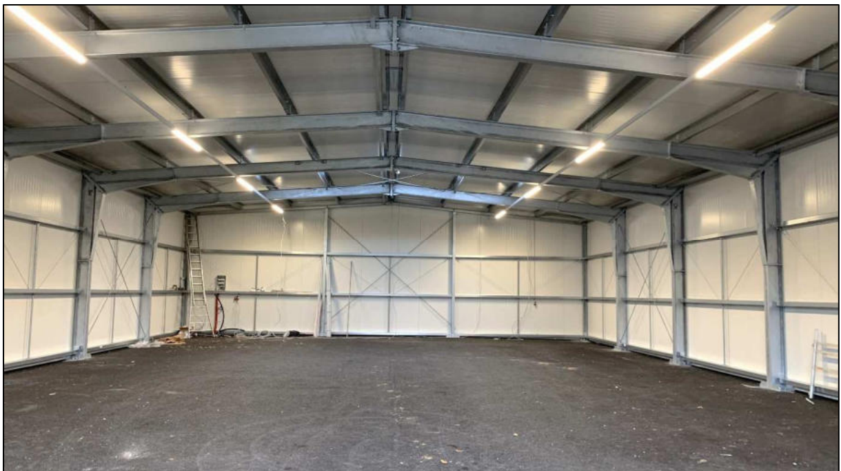
Abbildung 9 - Stahl-Rahmenbinder mit Stahlpfetten
