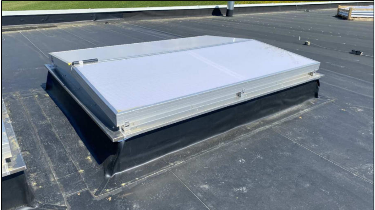
Abbildung 37 - Dachbelichtung mittels einzelner Kuppeln (Ausführung auch als RWA-Rauch-Wärmeabzug möglich)
