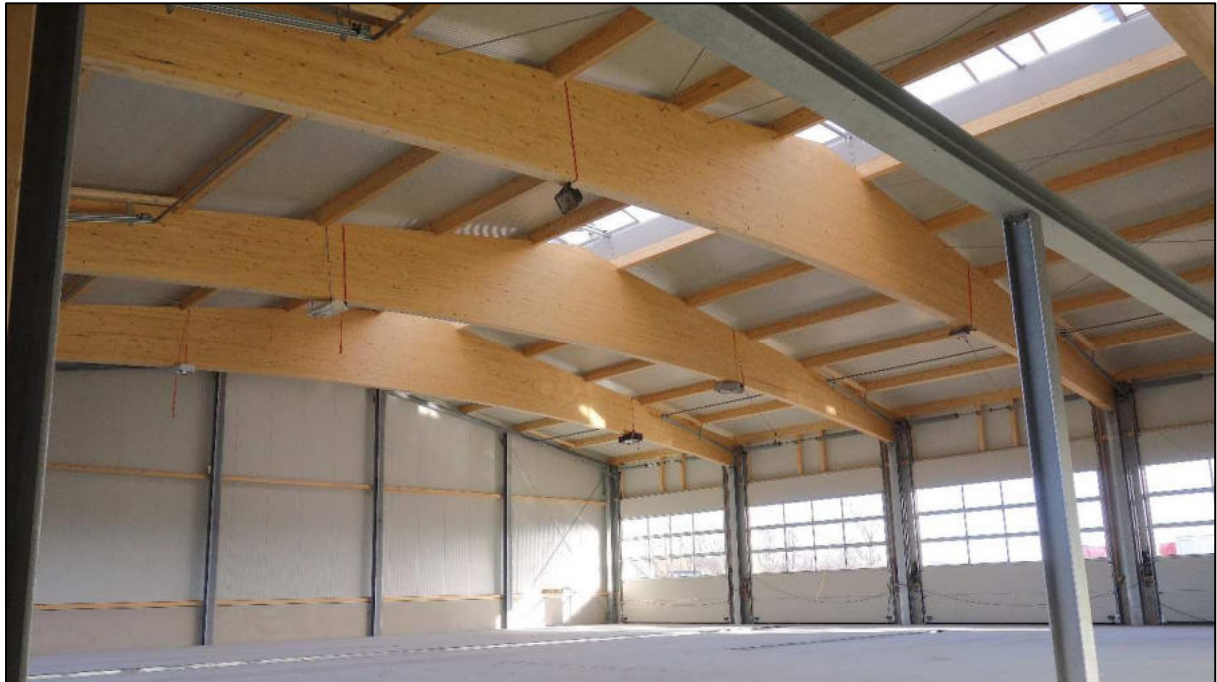
Abbildung 14 - Leimholz-Satteldachbinder mit Stahlstützen
