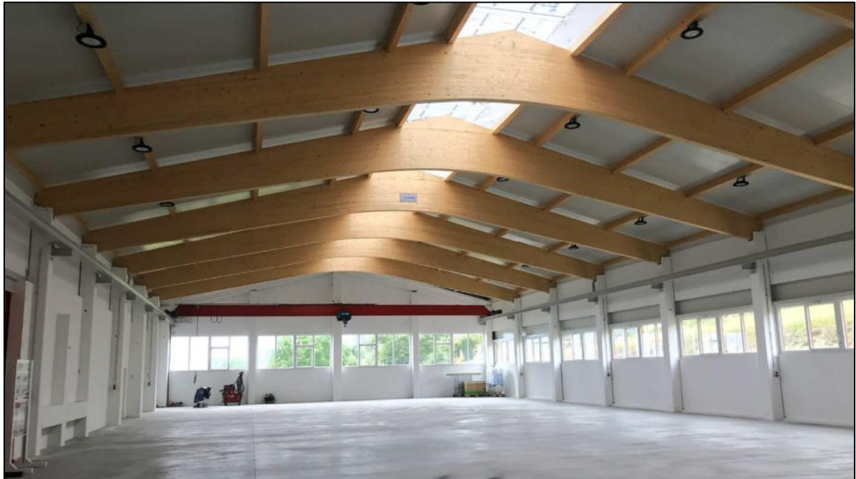
Abbildung 12 - Leimholz-Satteldachbogenbinder mit Betonstützen
