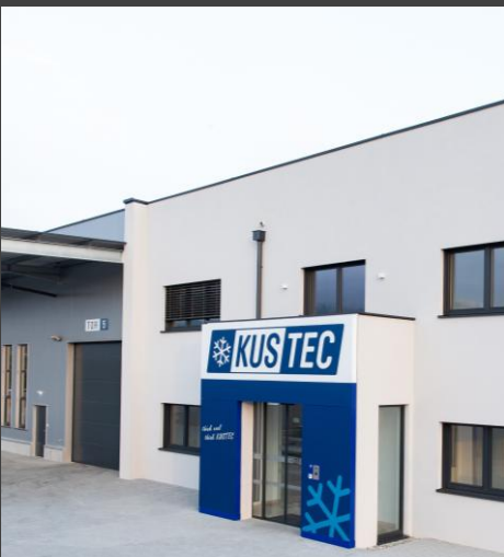
KUSTEC - KÄLTE- UND SYSTEMTECHNIK GMBH, 3441 FREUNDORF (NÖ)
