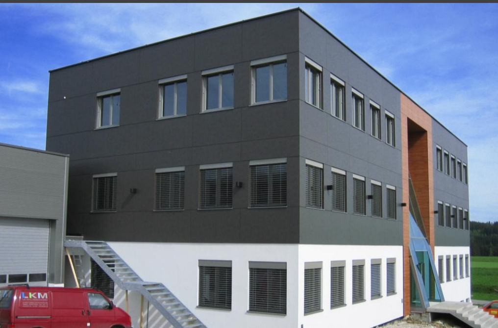
TGZ ERRICHTUNGS- & BETRIEBS GMBH, 4190 BAD LEONFELDEN (OÖ)
