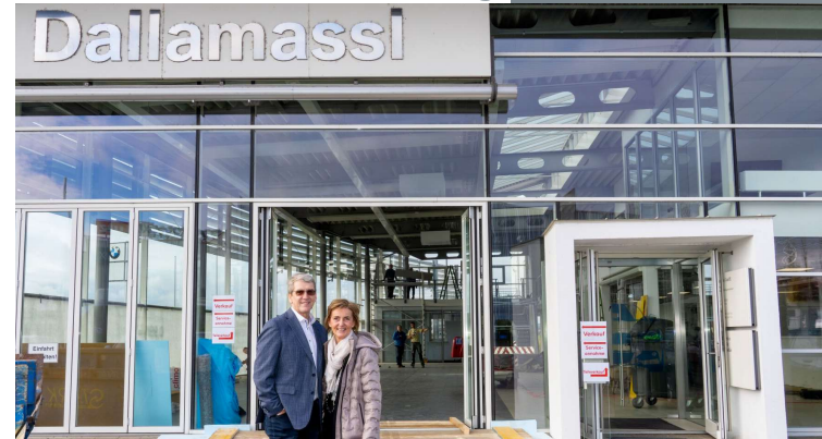
▲ Auch von außen spielt das Autohaus Dallamassl nach dem Umbau alle Stücker. Fotos: Eduard Reiningger
