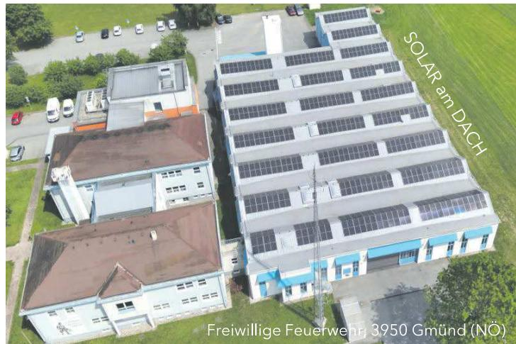
Durchdringungsfreie PV-Unterkonstruktion 220kW Wechselrichter
