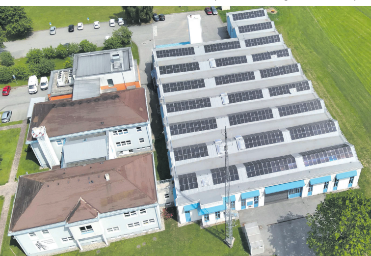
Freiwillige Feuerwehr, 3950 Gmünd (NÖ) Durchdringungsfreie PV-Unterkonstruktion 220kW Wechselrichter 524 Module mit einer Modulspitzenleistung von 233kWp.
