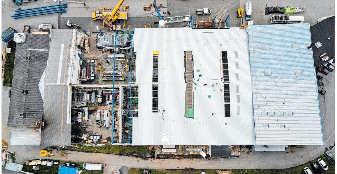
Die alte Werkshalle der Henkel Betriebs GmbH wurde im laufenden Betrieb schrittweise durch eine neue 3.200 Quadratmeter große Halle ersetzt. Nach nur einem Monat war das neue Dach schon dicht.
