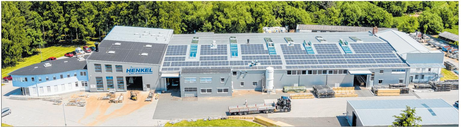
Die Photovoltaikanlage auf dem Dach der neuen Werkshalle liefert eine Spitzenleistung von 205 kWp und soll rund ein Drittel des Jahresstrombedarfs des Heiz- und Elektropoliertechnik-Unternehmens Henkel abdecken.
