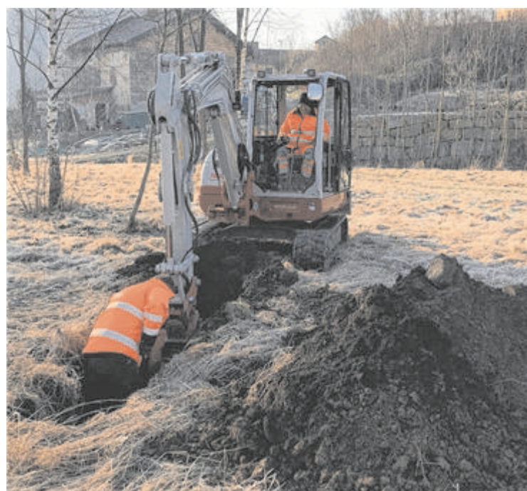
Am Montag wurde umgehend mit der Schadensbehebung begonnen: auf dem Bild Ewald Kases bei den Baggerarbeiten und Herbert Bauer bei den Grabungsarbeiten. Foto: Stadtgemeinde Waidhofen
