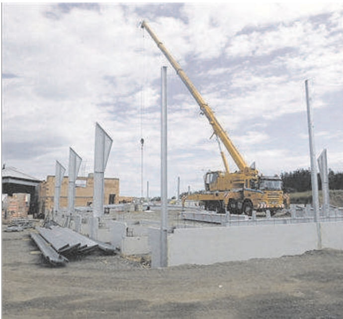
Ein Eindruck von der Baustelle - die Halle im Entstehen.
