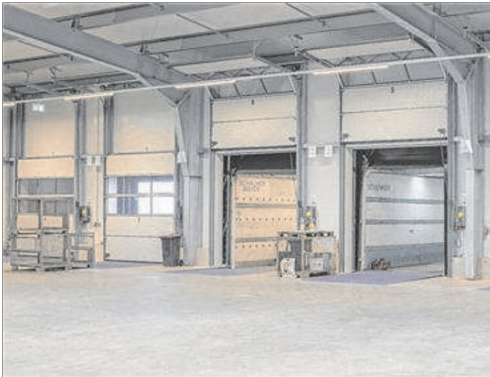
Hydraulische Andockkrampen ermöglichen ein effizientes Be- und Entladen.
