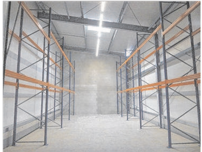
Für heikle Waren wurde ein beheizbares Warenlager eingerichtet.
